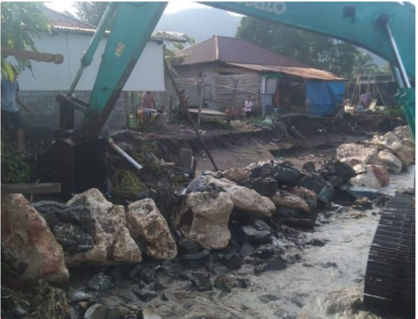
Proyek pemecah ombak di desa kolono
