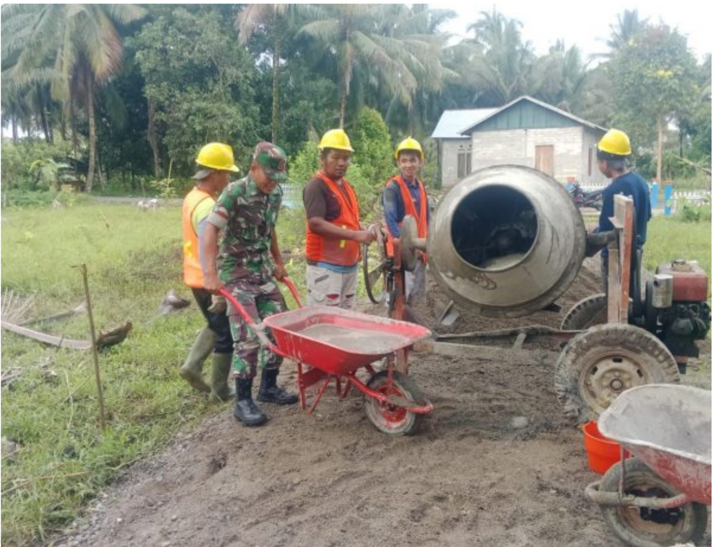
Babinsa Praka Sriyanto Ikut Gotong Royong Bangun Jalan
