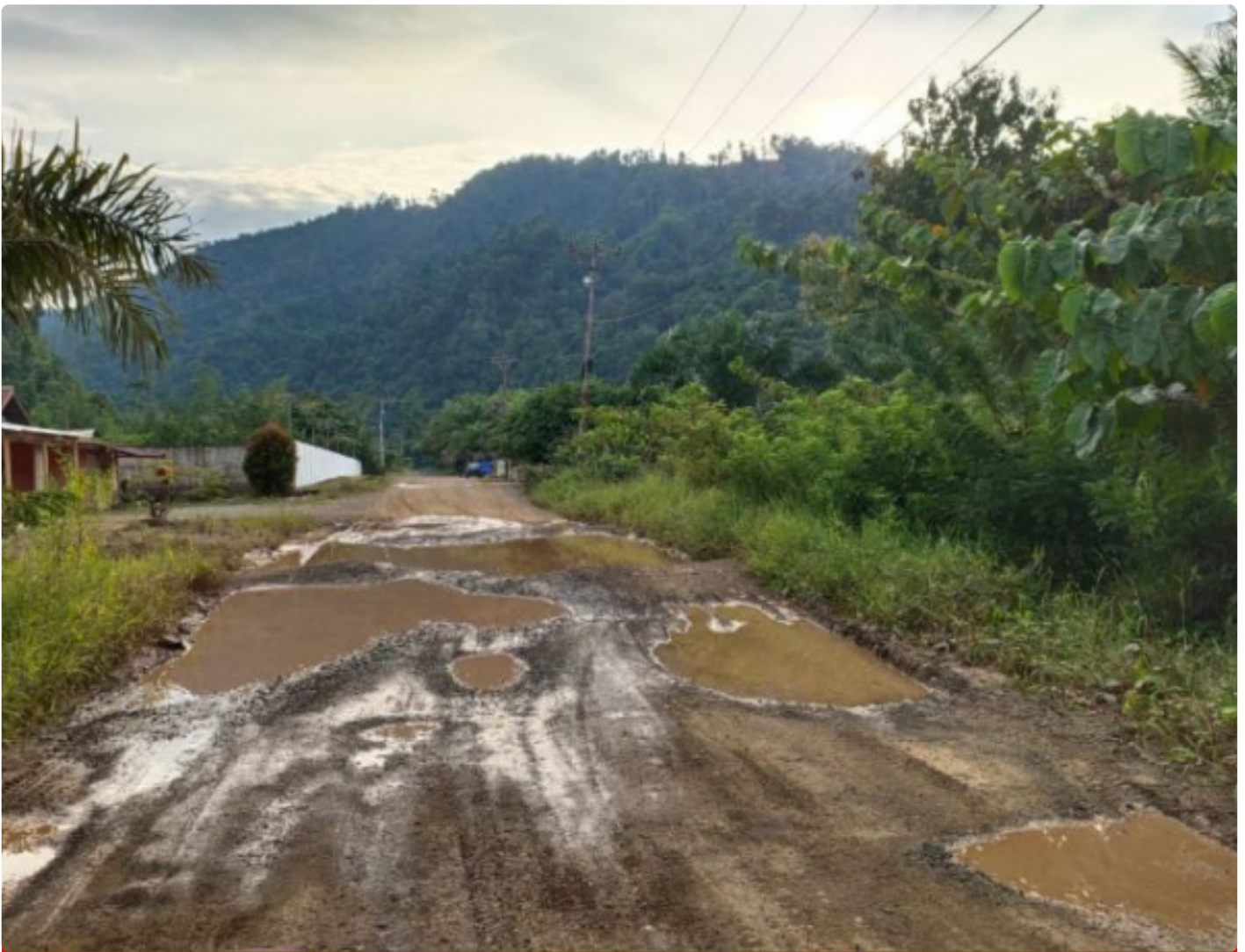
Tampak jalan poros Bimorjaya Mirip Kubangan Kerbau
